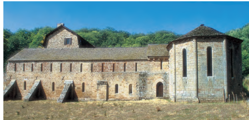
Façade est (chevet de l'église et bâtiment est).
