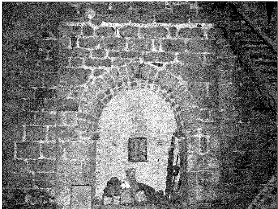
Fig. 7. – Eymoutiers, collégiale, clocher, salle haute, arc oriental.
