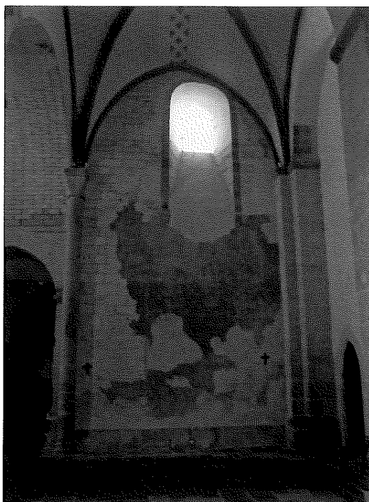
Fig. 5. – Eymoutiers, collégiale, mur ouest du bras nord du transept.
